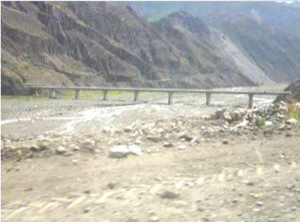
PUENTE PUNKU ESQUINA TRAMO MECAPACA – SECTOR ILLIMANI (DISTRITO PALCA)
