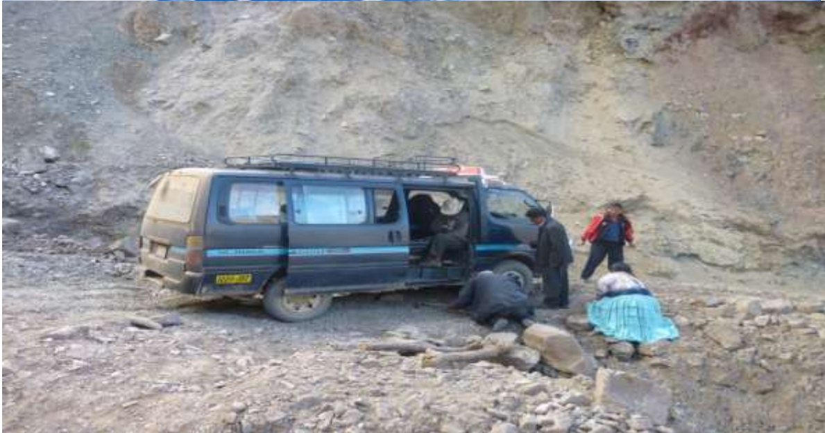
CARRETERA EN MAL ESTADO AL DISTRITO PALCA
